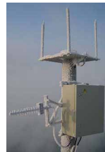
Рис.5 Пилон спутниковой антенны АСМ моста через р. Енисей вблизи Красноярска
