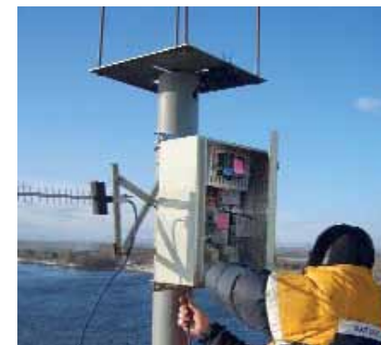
Рис.11 Монтаж блока аппаратуры системы мониторинга моста через р.Енисей вблизи Красноярска
