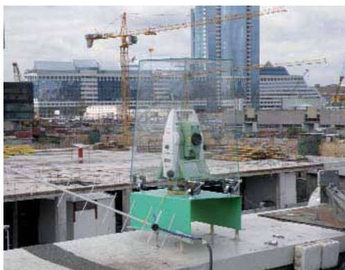
Рис.6 Электронный тахеометр для автоматического контроля за смещениями высотного здания комплекса Москва-Сити
